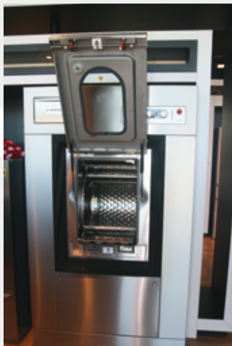
Barrieremaskin: Skitne innsatsklær legges i maskinen på den ene siden av veggen, og tas ut rene på den andre siden av veggen.
